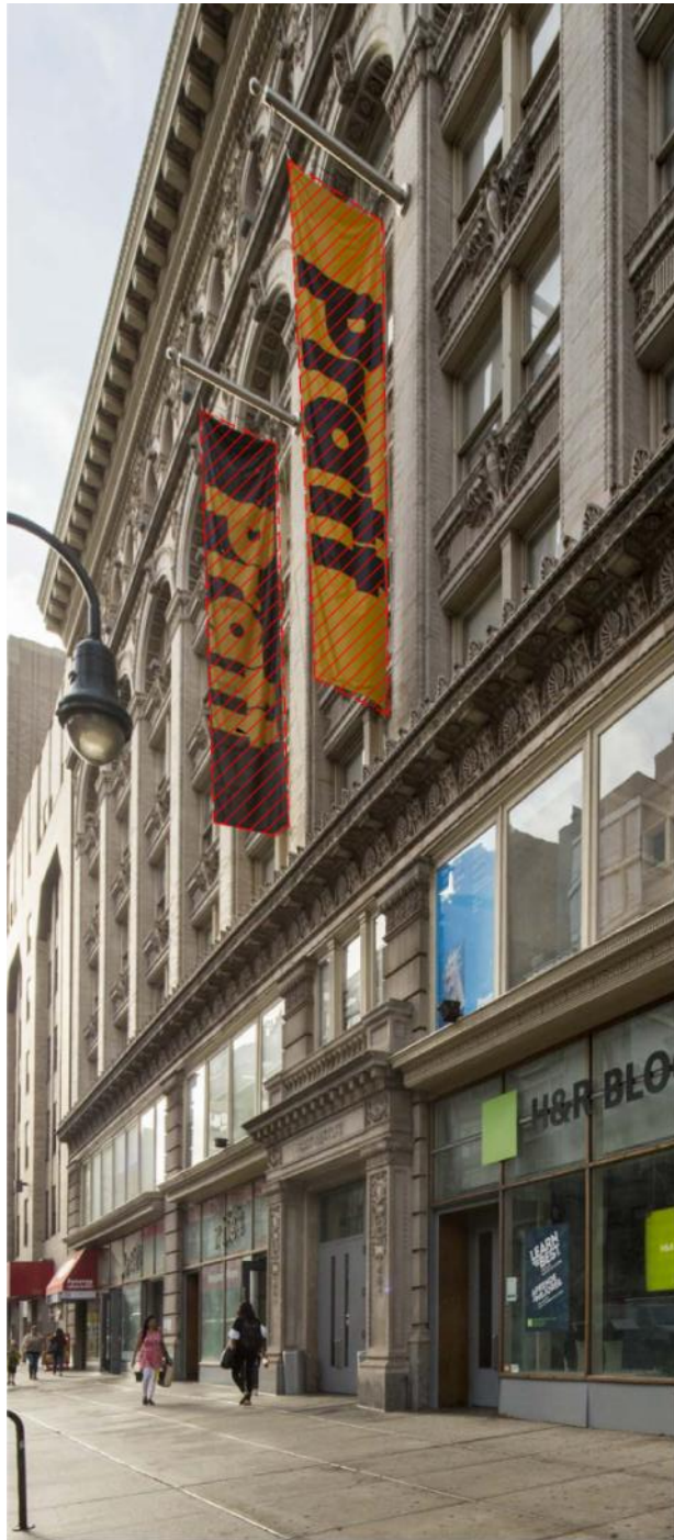
1 EXISTING SIGNAGE PHOTO N.T.S.
